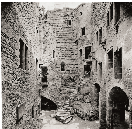
Abb. 3 a. und 3 b. Innenhof vor und nach der Restaurierung.
