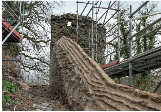
Abb. 8. Bischofsmütze oder Drachenbuckel? Neue Mauerkrone im westlichen Zwinger, Bauabschnitt 2016 (Foto: Verf., März 2017).
