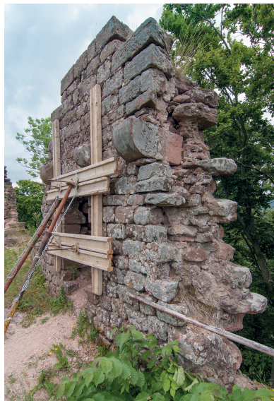
Abb. 4. Das Foto (Gegenrichtung zu Abb. 3) im Sommer 2008 zeigt ein Mauerwerk, das nur noch aufgrund einer nun deutlich aufwändigeren Verklammerung und Abstützung gehindert ist, sich gänzlich aufzulösen. Erste Sicherungsmaßnahmen laufen an (Foto: Verf.).
