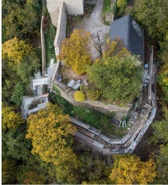
Abb. 12. Südöstliche Hälfte, Schrägaufnahme. Oben am Bildrand der angeschnittene Giebel des Palas, daran mittig anstoßend die ältere Ringmauer der oberen Burg mit den zugesetzten Zinnen. Links darunter die 2016 sanierte westliche Zwingermauer. Die Gerüste markieren den Bereich des Bauabschnitts 2017, beginnend links beim südlichen Eckturm des Zwingers und endend rechts unterhalb des dunkel gedeckten Daches eines Neubaus beim oberen Tor aus den 1980er-Jahren (Foto: Verf., 16. Oktober 2017).
