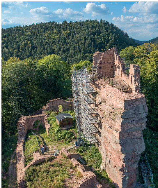
Abb. 13. Im südlichen Ende des Burgfelsens mussten aus Gründen der Stabilität einige horizontale Klüftungen mit Mauerwerk geschlossen werden. Die Gesamtmaßnahme nähert sich ihrem Abschluss (Foto: Verf., 1. September 2017).
