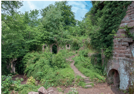
Abb. 12. Völlig überwuchert zeigte sich die untere Burg im Jahre 2008. Blick in Richtung auf das innere Tor (linker Bildrand). In der Bildmitte darüber die Frontwand des gotischen Hauses mit Türöffnung und Fenstern; rechts angeschnitten die Buckelquaderverkleidung des Brunnenschachts. Zu den genannten Bauteilen (vgl. auch Abb. 13) (Foto: Verf.).
