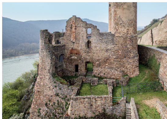
Abb. 2. Blick auf die Eingangsseite von Osten. Im Vordergrund links der Rest des äußeren Wohnbaues vor der Sanierung 1970; am Schildmauerturm rechts noch umfänglich erhaltener Putz. Der angeschüttete Weinbergsweg im Halsgraben lehnt sich in fast voller Breite gegen die Basis der Schildmauer (Foto: Verf., 1967).
