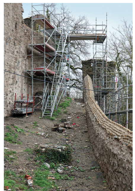
Abb. 5 bis 7. Links: Ringmauer der oberen Burg; Außen-seite mit Andeutung zugesetzter Zinnen (angeschnitten der Ostgiebel des Palas) (Foto: Verf., März 2017). Mitte: Zwingermauer Westseite von außen mit neuer Mauerkrone (Foto: Verf., Oktober 2017). Rechts: Westlicher Zwinger Blick südwärts mit neuer Mauerkrone; im Hintergrund die Ruine des Eckturms (Foto: Verf., März 2017).
