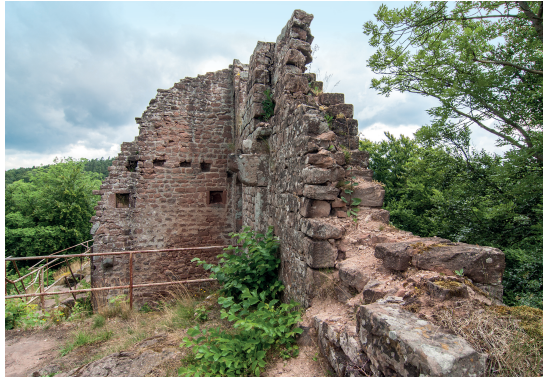
Abb. 11. Auch der noch umfänglicher erhaltene nördliche Teil des Südpalas in der Mitte der Oberburg war vor den aktuellen Maßnahmen in hohem Maße gefährdet. Insbesondere die Ostwand (rechts im Bild), die das vierteilige Fenster enthält, hatte seit einer ersten Sicherung in der ersten Hälfte des 20. Jahrhunderts bereits erheblich an Substanz verloren (Foto: Verf., Sommer 2008).
