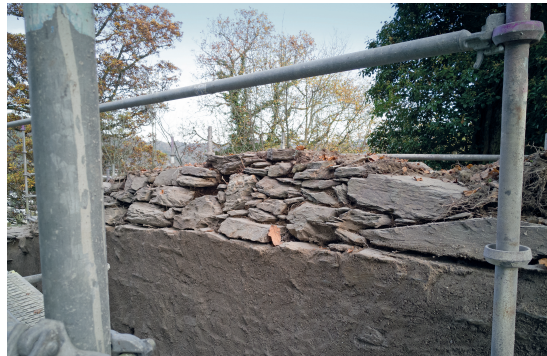
Abb. 9. Originaler Aufbau der Bischofsmütze aus Schieferbruchstein mit unregelmäßig engem Fugenbild (Foto: Verf., Oktober 2017).
