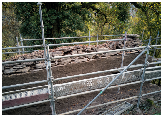
Abb. 11. Dieselbe Mauer, Mauerkörper bereits deckend mit Spritzmörtel behandelt, originale Bischofsmütze nach Entfernung der Pflanzen. Zustand 18. Oktober 2017 (Foto: Verf.).
