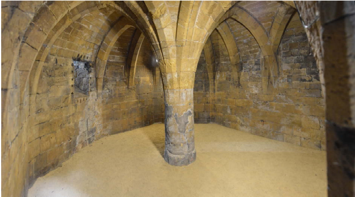
Abb. 14: Panorama des Kellers von der Treppe nach Norden (Foto: Verfasser)
