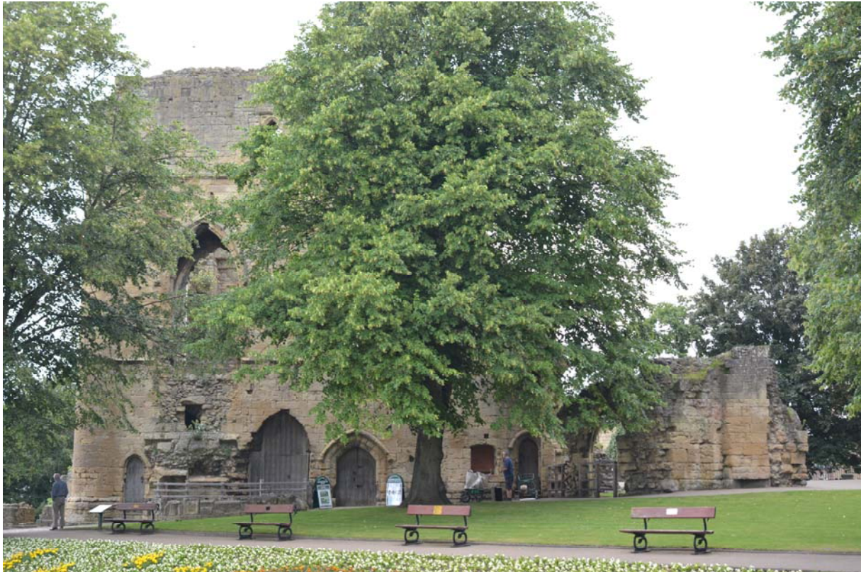
Abb. 1: Ansicht des Kingskeep von Knaresborough Castle (Foto: Verfasser)
