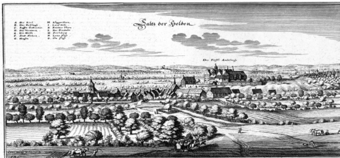
Abb. 10 Ansicht der Residenz Salzderhelden
