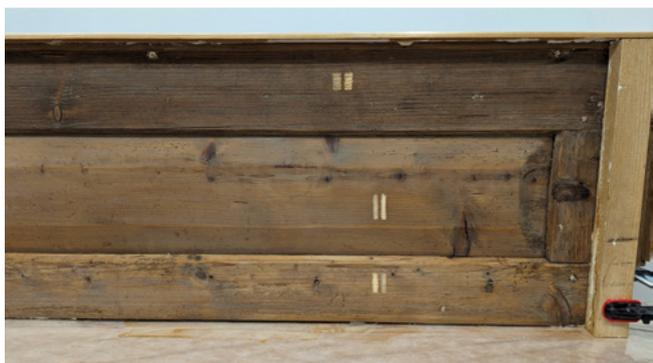
9 Nachzustand – Nach der Behandlung mit der Aceton/Methanol 4/1 +  $\gamma$ -Alumina Gelkompressse)
