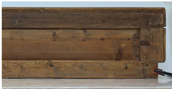
8 Vorzustand – Detail der Rückenlehne in Rahmen-Füllung-Konstruktion
