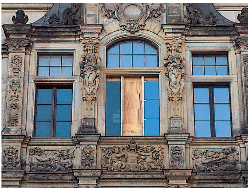
24 Dresden, Residenzschloss, Georgenbau, links Installation von Mustergläsern mit hoher Lichtschutzwirkung, rechts historisches Flachglas der Bestandsfenster
