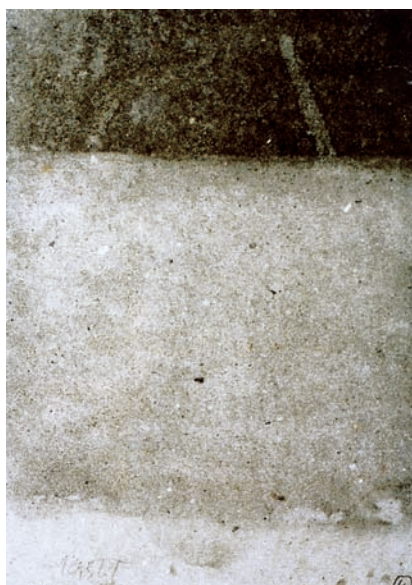
8 Firnisextraktion durch kleinteilige Klucelkompressen
