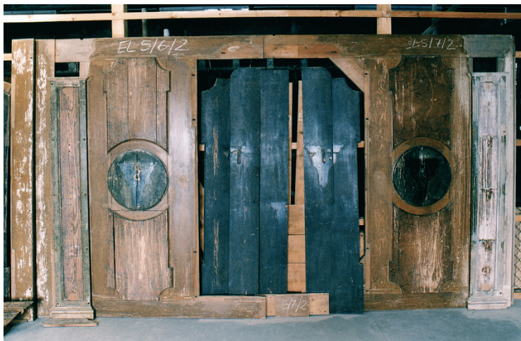
12 Elfenbeinzimmer, Vorzustand eines Wandfeldes nach Zuordnung aller erhaltener Bauteile, 1998
