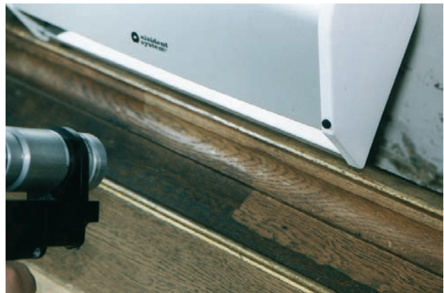
11 Abnahme von Überzügen durch Lasereinsatz, 2001
