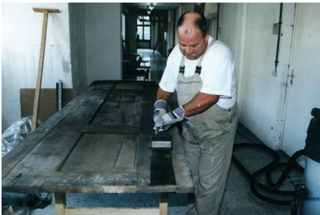
10 Rückseitige Reinigung eines Panels durch Vakuumwasch- verfahren, 2000
