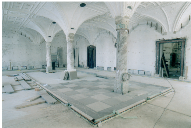
47 Pretiosensaal, Raumaufnahme nach Südosten während dem Wiedereinbau des Marmorbelages, 2004
