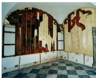
25 Weißsilberzimmer, Probeaufstellung der holztechnisch wieder- hergestellten Brett- verkleidungen, 2002
