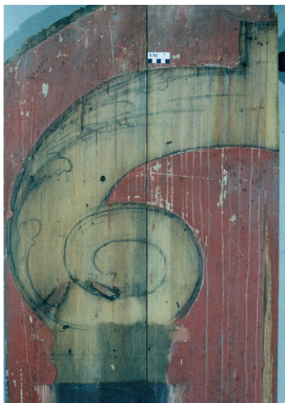
22 Weißsilberzimmer, Vorzustand, Detail eines Wandfeldes mit bauzeitlicher Vorzeichnung und überarbeiteter Ori- ginalfassung, 1999
