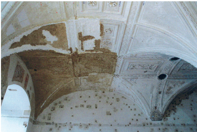
40 Pretiosensaal, Stuckdecke, wie- dergewonnenes Detail nach der Freilegung, 2002
