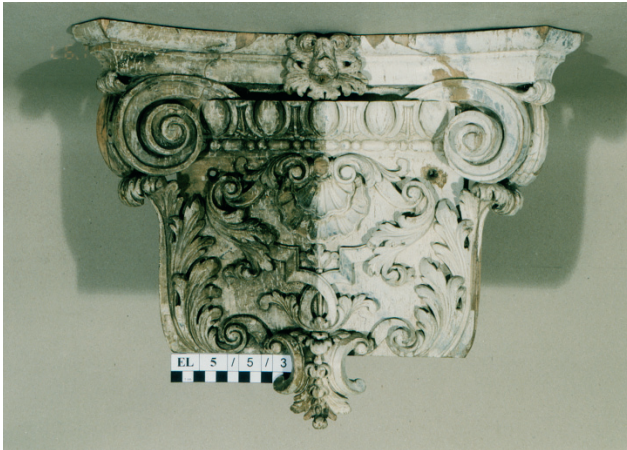
16 Elfenbeinzimmer, Abnahme der Überarbeitungsfassung an einem Kapitell, 1997
