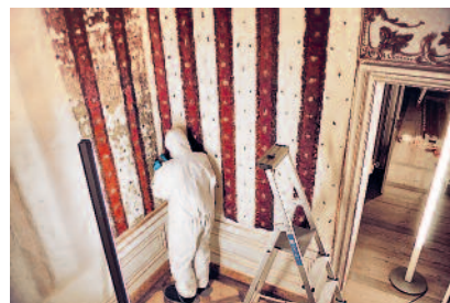
17 Während des Anbringens der großen Federtapeten an die Westwand
