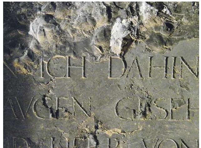
12 Schädigung der Schriftplatten aus Kohlekalkstein durch Salzmigration am Ulrichmonument, 2010
