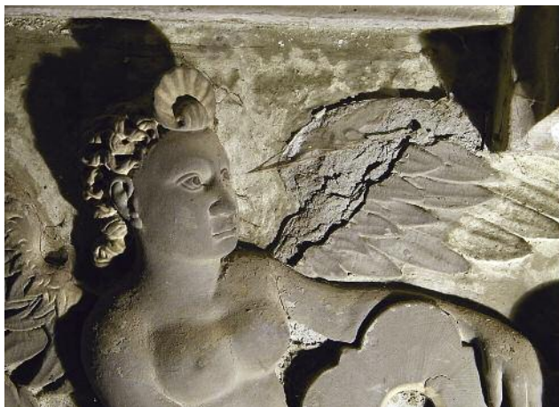
14 Schädigung eines Reliefs mit schicht- paralleler Aufspaltung und Abbrüchen am Sockelbereich des Borwinmonuments, 2011
