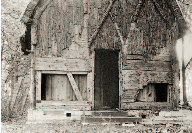
2 Eremitage 1964, Nordseite. Die Dokumentation der mechanischen Schäden an den Nischenrückseiten ermöglichte 2015 die Zuordnung der Nischen an ihren ursprünglichen Standort.
