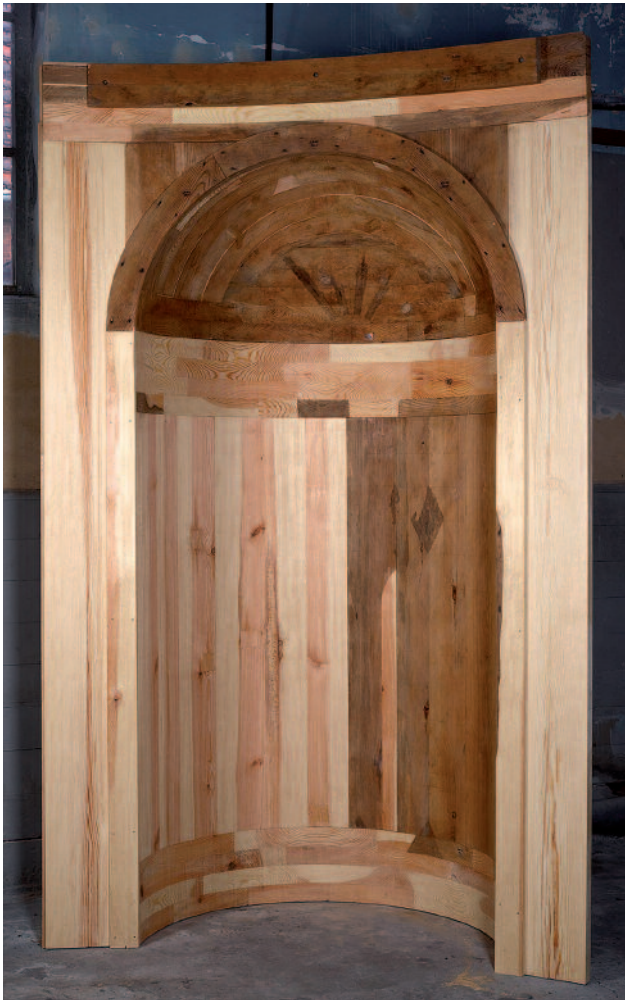
13 Vertäfelungssegment mit Nische nach der Restaurierung
