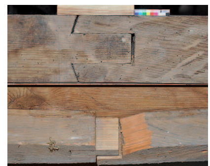
7 Blindholz der Vertäfelung, unterschiedlich ausgeführte Längsverbindungen. Oben: Zapfenstoß mit schräger Brust; unten: Schlitz-Zapfen-Verbindung mit Fremdzapfen
