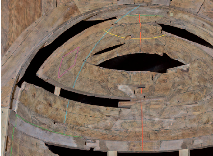
10 Vertäfelung, Kalotte mit Aufrisslinien. Rot: Mittenriss, blau: vertikale Rautenteilung, gelb: horizontale Rautenteilung, magenta: sphärisch verkrümmte Raute
