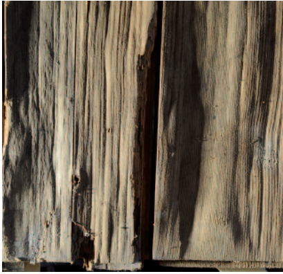
5 Täfelungselement der Eremitage, Oberseite, ehemals furniert, Deformation des Blindholzes durch holzerstörende Pilze
