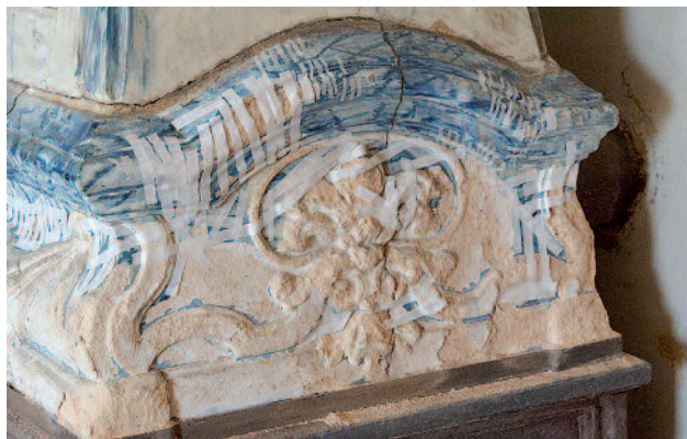
14 Braune Flecken unter der Glasur, durchgedrückter Ruß
