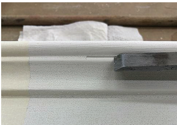
4, 5 Abziehen der Profilleisten mit verschiedenen Repariereisen
