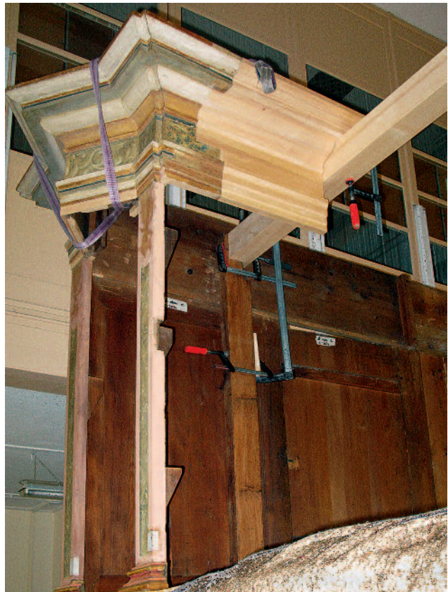
6 Profilkranzverlängerung und Balken an der ursprünglichen Stelle, linke Seite
