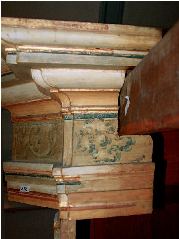
5 Abgekürzter Profilkranz mit nach vorn versetztem Auflagebalken
