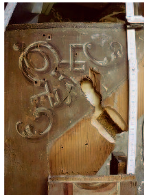
3 Schaden durch Elektroinstallation
