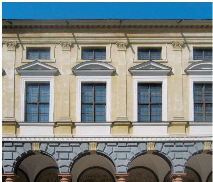
7 Stadtresidenz Landshut, Fassa­denansicht Innenhof, Fenster mit dunklem Lichtschutzscreen. Im Vergleich zu Abb. 3 wird der äs­thetische Gewinn bei der Fassa­denansicht deutlich.
