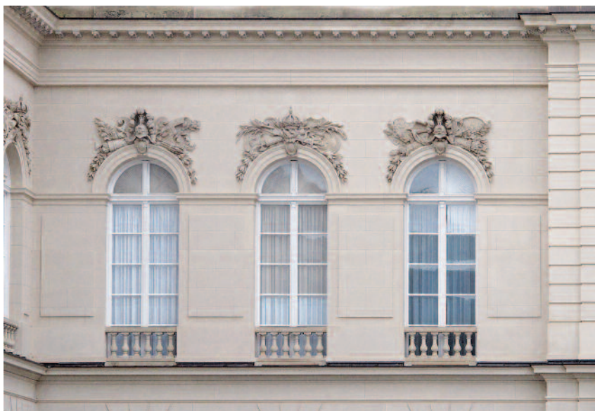
5 Neues Schloss Herrenchiemsee, Mittelbau Hofseite, unzureichender UV-Schutz verschiedener Generationen und Fabrikate von UV- und Sonnenschutzfolien. An den klaren Scheiben links im Bild ist die vergilbte UV-Schutzfolie bereits abgenommen. Die grauen Folien am rechten Fenster wurden zu unterschiedlichen Zeiten angebracht, offenbar verwendete man getönte Fabrikate.
