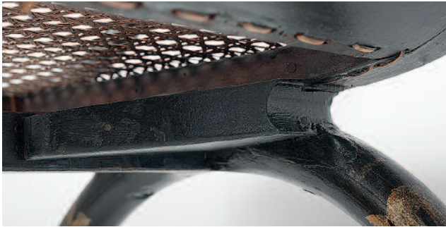
3 Armlehnstuhl, Steg und Holzwinkel, Unterseite Sitzfläche
