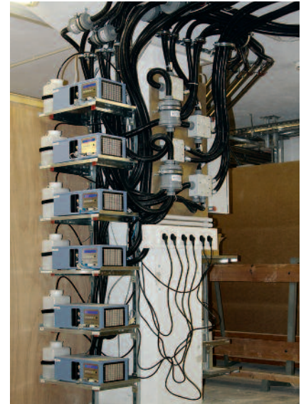
18 Zentrale Konstant- feuchtgeräte mit Verstärkungsventi- latoren und Aktiv- kohlefiltern
