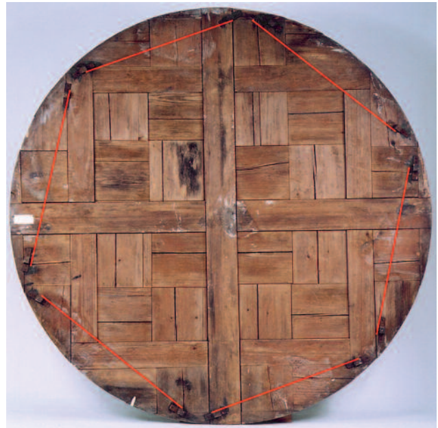
14 Tisch aus dem Bernhardzimmer, Unterseite des Tischblatts mit den Spuren der Eisenlaschen zur Befestigung eines wohl ein sechseckigen Tischgestells
