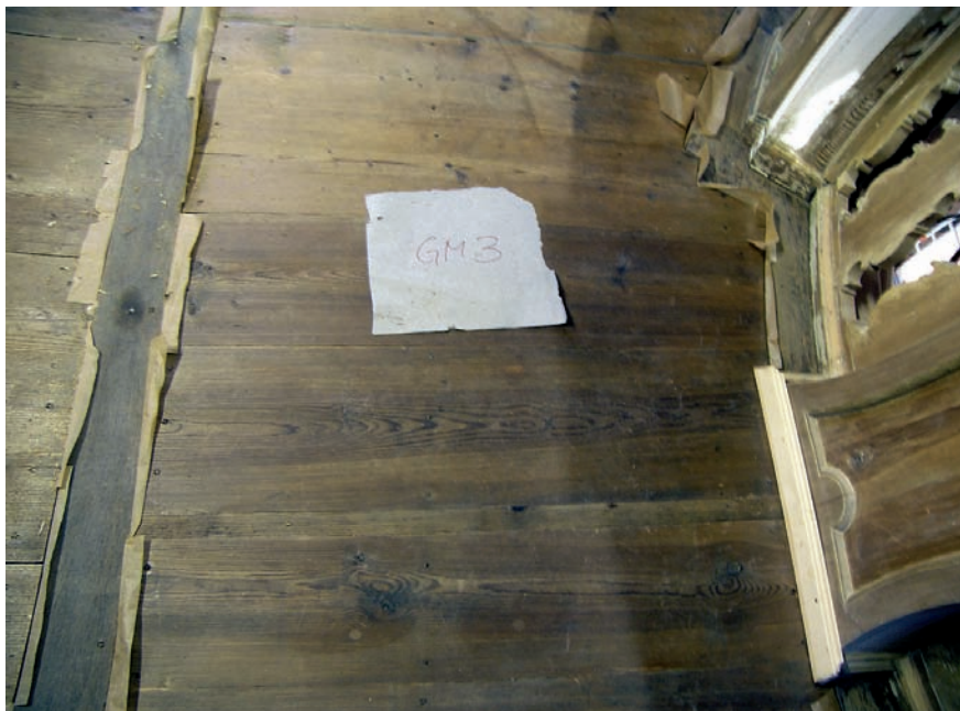
40 Dielung 2. Obergeschoss (O. Ehrhardt), eines der verlegten Fußbodensegmente nach den restauratorischen Maßnahmen
