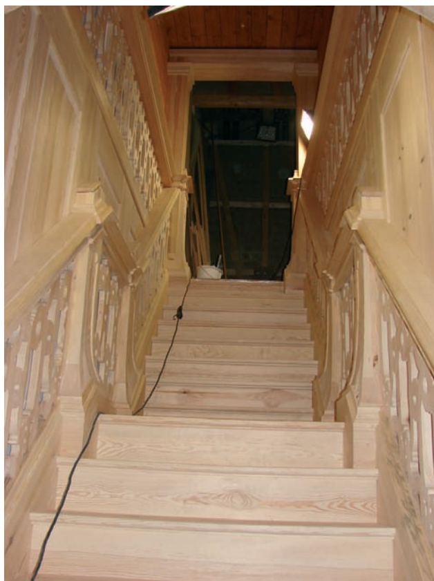
36 Treppenanschluss 2. Oberge- schoss (K. Püschner); restaurierter Bereich und Beginn der Rekon- struktion der Treppe mit Geländer
