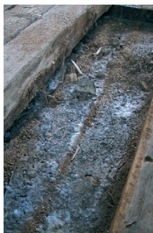
19 Freigelegte Balkenlage 1. Obergeschoss über dem Renaissancegewölbe; kontaminierte Füllschüttung
