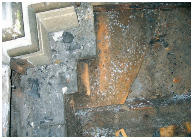
20 Während des Ausbaues der Fußbodenlage 1. Ober- geschoss; Kontamination durch Schimmelsporen
