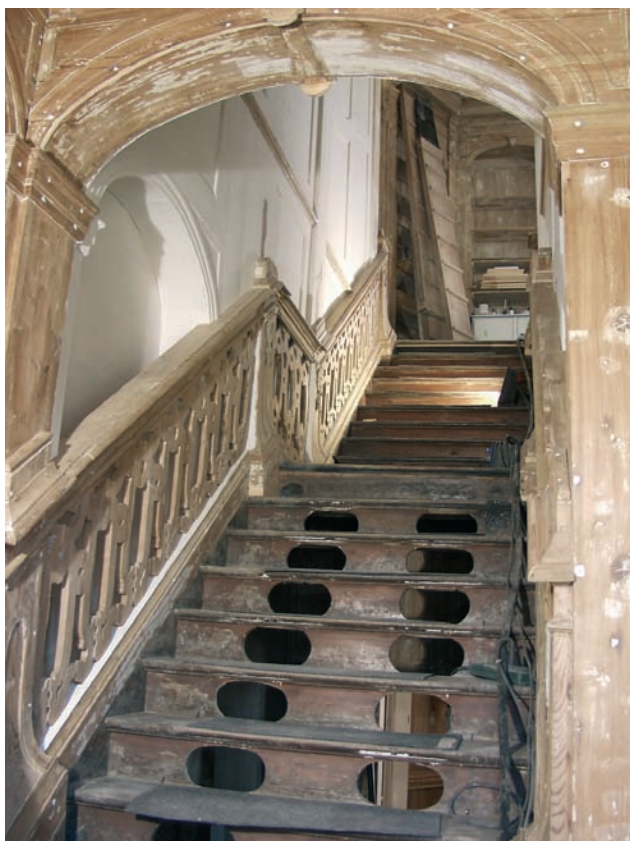
34 Nach dem Brand, Zerstörung der Treppe durch den Brand bis zum Mansardgeschoss
