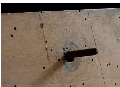
11 Detail des Bodenbretts: Anrisslinien gehen strahlenförmig von einem Zentrum oberhalb des Schraubenschaftes aus.
