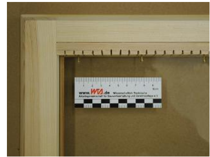
14 Zahnleiste mit Messingschrauben zum Spannen der Lamellen
