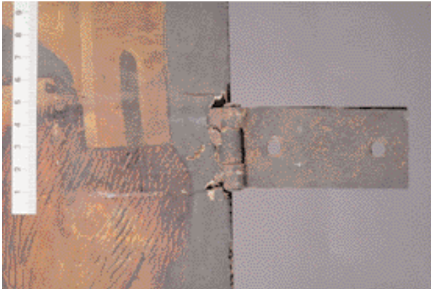
2 Detail, Scharnier am linken äußeren Flügel
