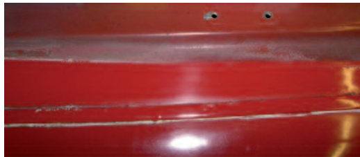
15 Farbgebung der originalen Werks- lackierung in Coral Red (oben) und der späteren Neulackie- rung (unten)
