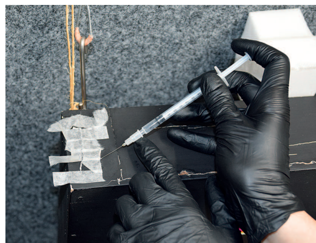
8 Einbringen des Klebstoffes mittels Kanüle
