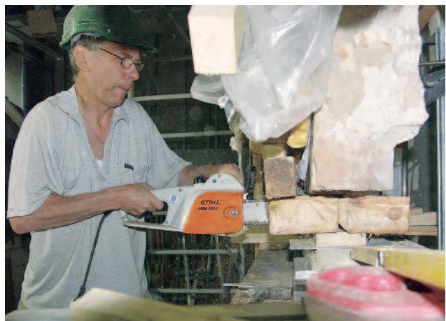
15 Restaurator beim schrittweisen Rückbau der Holzbalkenkonstruktion von 1893
