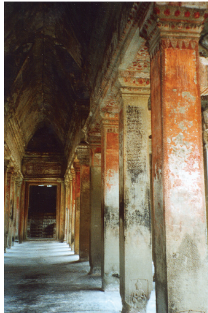
4 Kreuzförmige Galerie; Rote Farbspuren, Ausbesserungen, Ruß und Inschriften ergeben ein heterogenes Bild. Die Inschriften wurden meist mit einer schwarzen lackartigen Schicht hinterlegt, um die „Lesbarkeit“ zu verbessern.
