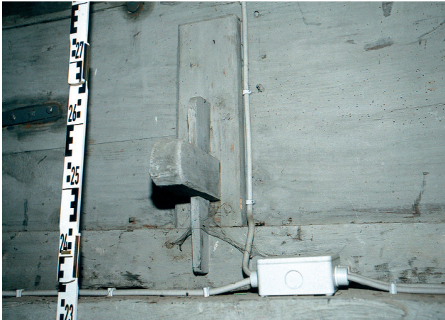
5 Keilsicherung des Schalldeckels an der Rückseite des Gesimsbrettes des Ahrenshagener Kanzelaltars
