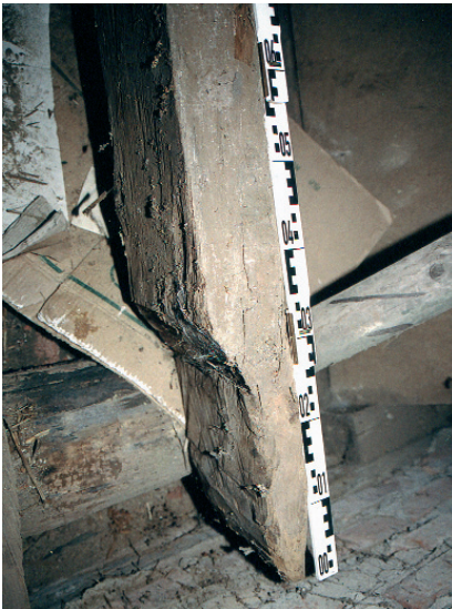
14 Detailaufnahme des unteren Endes eines Stützbalkens. Vermutlich steckte der einseitig angeschrägte Balken in einem lastverteilenden Fußholz.
