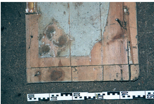
12 Detailaufnahme der Kanzelrückwand. Auf der rechten Seite der Abbildung sind Konturen des verschollenen Kanzelkorbes zu erkennen. Unten ist der 6,3 cm breite Falz sichtbar, der das untere, waagerechte Konstruktionselement verdeckt (vgl. Abb. 13).
