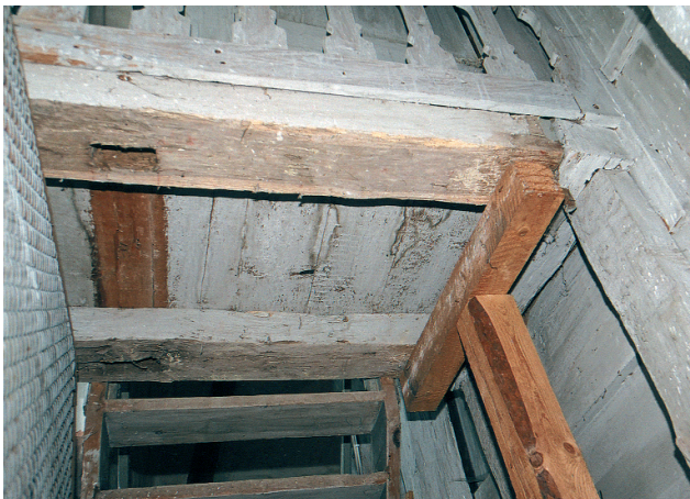
6 Detailaufnahme der Unterkonstruktion des Kanzelaltars in Ahrenshagen: Zwei waagerechte, durch die Rückwand gesteckte Balken (nachträglich durch Stempel unterstützt) tragen das obere Treppenpodest und den Kanzelkorb auf der hier nicht sichtbaren Schauseite.
