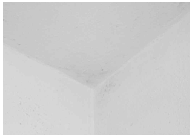
17 Riss im Wandputz, Zustand vor der Restaurierung
