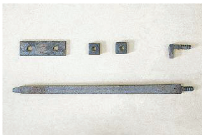
11c Demontierbare und wiederverwendbare schmiedeeiserne Elemente für die Ver- sockelung
