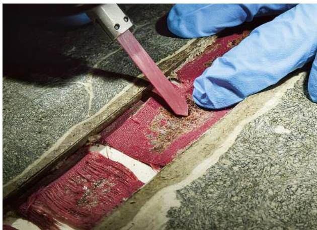
9 Entfernung von Bindemittelresten mit Hilfe eines Ultraschallmeißels
