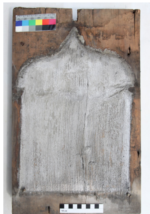
8 Umgebindehaus, Obercunnersdorf/Oberlausitz, Südseite, Umgebindeständer nach Abnahme des Verkleidungsbrettes
