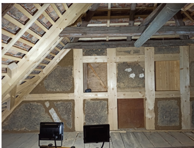
11 Umgebindehaus, Obercunnersdorf/Oberlausitz, Dachgeschoss, nach erfolgtem Einbau der originalen Gefache
