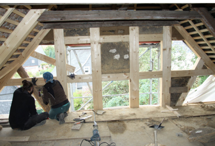
10 Umgebindehaus, Obercunnersdorf/Oberlausitz, Dachgeschoss, Südseite, nach Austausch maroder Balken werden die Gefache wieder eingebaut
