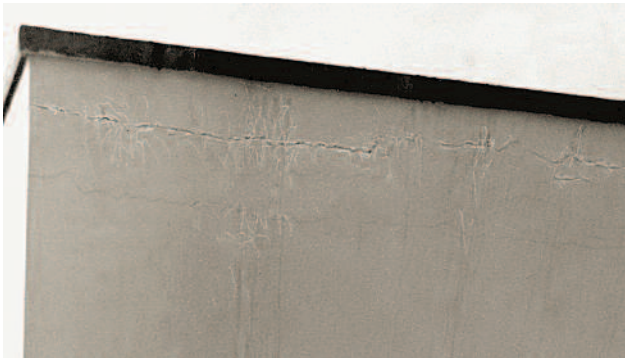
6, 7 Ludwig Mies van der Rohe und Lilly Reich, Haus Tugendhat, Brunn (1930), Südostfassade; oben: Das Foto ist retuschiert, um auf der Putzfläche Elemente der Faktur und der Alterung zu eliminieren; unten: Detail der Wand des Schlafzimmers von Grete Tugendhat. Der Riss zwischen Betondecke und Ziegel-Ausriegelung, ein Baumangel, ist retuschiert.
