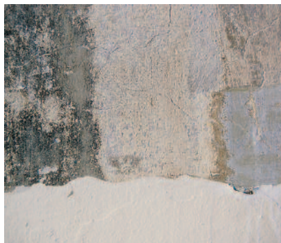
13 Dessau, Bauhaus, Prellerhaus (1926), Ostfassade, Detail, Proben zur Entfernung späterer Beschichtungen. Auf dem geglätteten rötlich-gelblichen Putz (Frühschwindrisse!) liegt eine dünne Kalktünche gleicher Farbe, wahrscheinlich mit silikatischen Sand-Feinanteilen gefärbt. Die Oberfläche ist patiniert und auch vergipst. Analyse Nils Mainusch, HAWK, 2000
