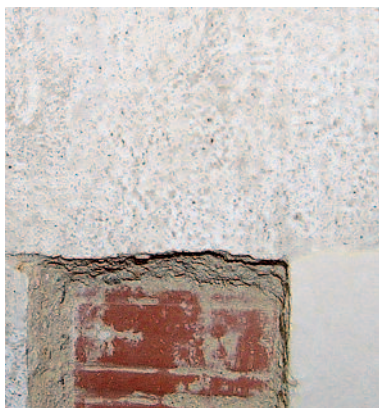
15 Brno, Messegelände, Pavel Janák, Pavillon der Kunstgewerbeschule Prag (1928), originaler Fassadenputz: die Oberfläche gerieben, mit dünner heller Fresko-Kalktünche, ähnlich wie später am Haus Tugendhat, Studienarbeit HAWK Hildesheim, Silke Heinemann und Jan G. Menath, 2005
