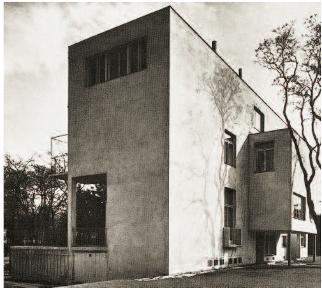
18 Josef Frank und Oskar Wlach, Haus Beer in Wien-Hietzing (1930) von Nordwesten. Auf der Nordfassade sind die Spuren der Faktur zu sehen: Gerüstgrenzen, Unregelmäßigkeiten.
