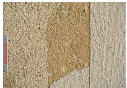
8, 9 Ludwig Mies van der Rohe und Lilly Reich, Haus Tugendhat, Brunn (1930), obere Terrasse, nach Südosten, oben: „Archäologisches Fenster“ (campione), das die originale Fassadenoberfläche zeigt. Die rekonstruierte Kalktünche der übrigen Fassadenfläche ist heller gehalten, weil sie durch die Alterung nachdunkelt; unten: Detail, während der Entfernung der späteren Überputzungen (von rechts nach links): Anstrich von 1985 (mit Zement und Kunstharz), zwei stark vergipste Kalktünchen (zwischen 1945 und 1965), originale Oberfläche mit gelblicher Tünche (Bildunterkante ca. 17 cm)
