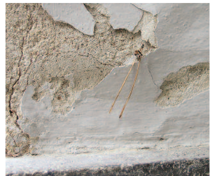
14 Dessau, Meisterhaus Klee/Kandinsky (1926). Unter dem rezenten, möglicherweise einen Kunstharzanteil enthaltenden titanweißen Anstrich tritt der ursprüngliche materialfarbige geglättete Putz zutage, 2006.
