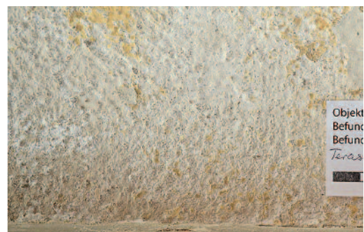
19 Josef Frank und Oskar Wlach, Haus Beer in Wien-Hietzing (1930), Dachterrasse, Sonnenbad-Nische, Decke, originale Fassadenoberfläche mit Resten von vier späteren Über-tünchungen und Salzausblühungen, mit Feinsilikaten pigmentierte gelbliche Kalktünche auf geriebenen Kalk-putz
