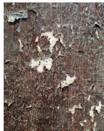
2 Salzburg, Nonnberg, Stiftskirche, Wandmalerei Mitte 12. Jahrhundert., 1977 durch Sebastian Enzinger abgenommen und auf einen mit Glasfaser verstärkten Epoxidharz-Träger (facing: Schellack, backing: Acrylharz) montiert. Die abgenommene Nische steht vor der benachbarten, in situ befindlichen Malerei, die Schäden durch Mikroorganismen und lösliche Salze aufweist. 1989–1971 wurden die übrigen Malereien durch Reinigung der Oberfläche, Desinfektion und durch Wiederherstellung des ursprünglichen, vor 1895 bestehenden und für die Erhaltung günstigen Raumklimas konserviert. Die nach der Entdeckung der Wandmalereien geöffneten Raumteile wurden mit Glasplatten verschlossen (Foto 1988).
