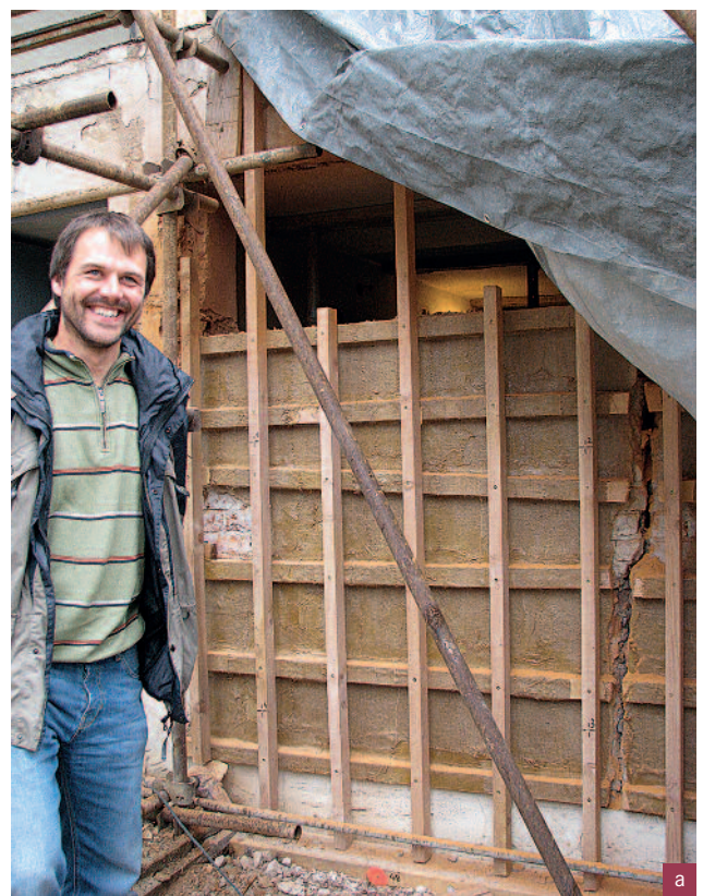
4 a und b Brünn, Tschechische Republik, Haus Tugendhat, 1930, Fassade der Gartentreppe. Konservierung des originalen Putzes durch temporäre Abnahme; 4a) Facing stabilisiert mit Holzkonstruktion, die verformte Ziegelmauer dahinter bereits abgearbeitet; Konservator-Restaurator Josef Červinka; 4b) Südwestfassade, nach Versatz des originalen Putzes an die ursprüngliche Stelle entsprechend geodätischer Vermessung und Aufbau der Ziegelmauer dahinter auf neuem Fundament (Foto 2010 und 2011)
