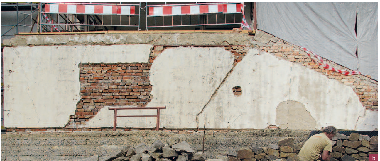
4 a und b Brünn, Tschechische Republik, Haus Tugendhat, 1930, Fassade der Gartentreppe. Konservierung des originalen Putzes durch temporäre Abnahme; 4a) Facing stabilisiert mit Holzkonstruktion, die verformte Ziegelmauer dahinter bereits abgearbeitet; Konservator-Restaurator Josef Červinka; 4b) Südwestfassade, nach Versatz des originalen Putzes an die ursprüngliche Stelle entsprechend geodätischer Vermessung und Aufbau der Ziegelmauer dahinter auf neuem Fundament (Foto 2010 und 2011)
