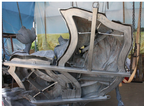
4 Edelstahl-Unterkonstruktion und Transportgestell in der Figurengruppe Pferd und Triton Südwest
