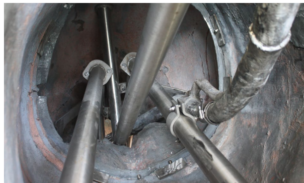
3 Die neue Edelstahl-Innenkonstruktion im Pferd Süd mit Halterungen für die Bleirohre
