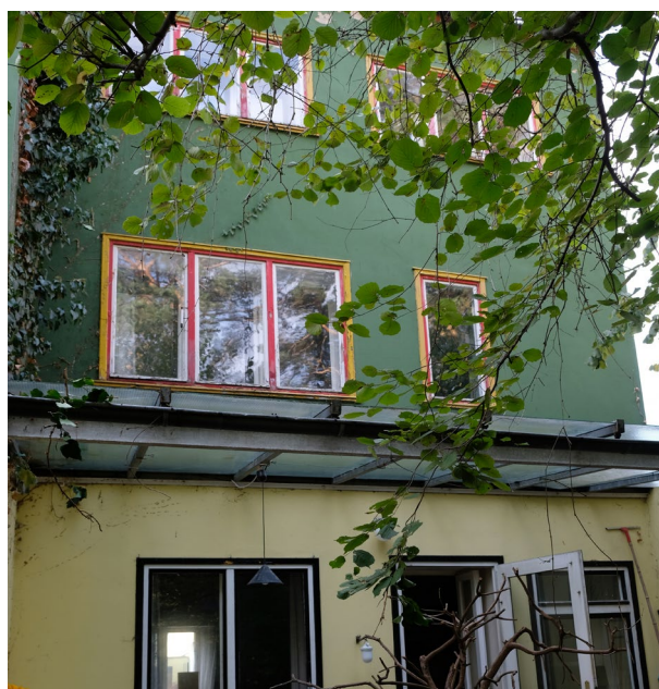
11 Ansicht der Ostfassade vor der Renovierung, 2020
