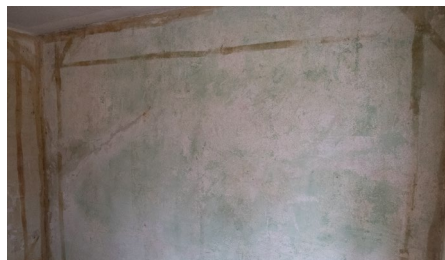
20 Sichtbare grüne Fassung nach Abnahme der Tapeten im Obergeschoss mit Blick nach Süden, Zustand 2020
