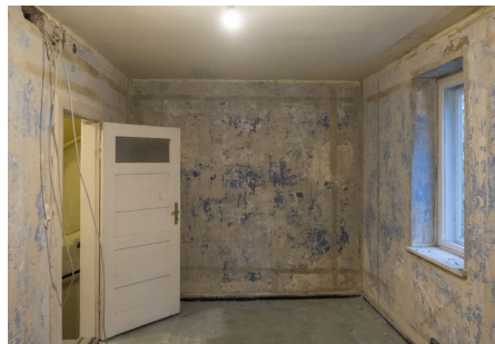
19 Sichtbare dunkelblaue Fassung nach Abnahme der Tapeten im Raum 2.2 im Obergeschoss mit Blick nach Norden, Zustand 2020
