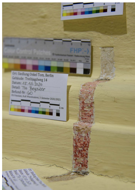
22 Freilegungsschnitt der roten Fassung auf dem wandseitigen Profil entlang der Treppen-Untersicht
