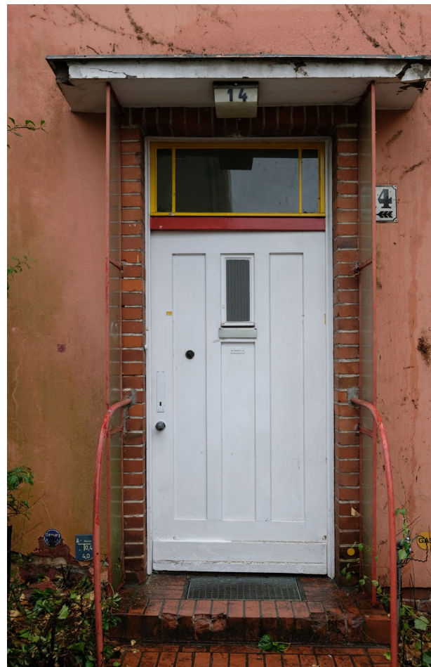
Abb.15 Hauseingangstür in der Westfassade, Zustand 2020
