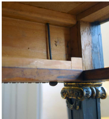
3 Hebemechanismus im Tisch (Mos 994). (a) Durch einen Knopfdruck von der Unterseite der Zarge kann die darüber liegende Steintafel angehoben werden.
