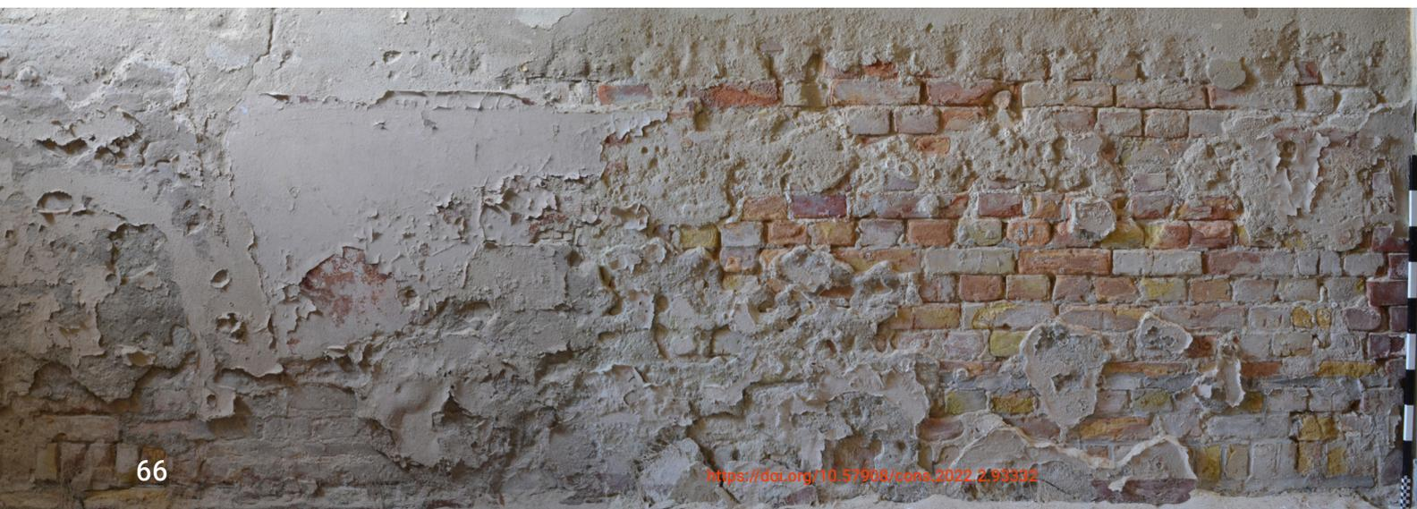
Die Grundrezeptur der ersten Kompressen ist aus dem Projekt Desalination<sup>6</sup> genommen. Sie besteht aus Arbocel, Bentonit und Sand (CBS-Kompressen) in einem Mischungsverhältnis von 1:2:9 in Masseteilen.
