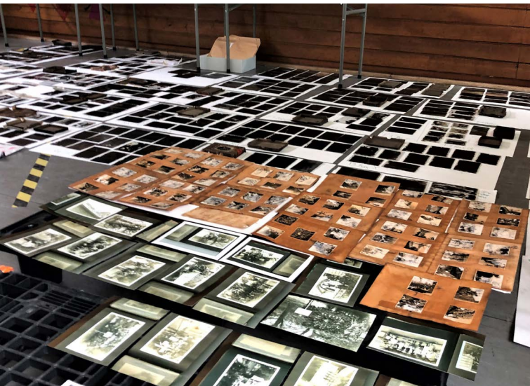
15 Lufttrocknung von Abzügen, Planfilmen und Glasplatten in einer Halle
