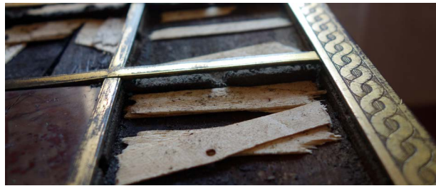
9 Massive Schädigungen der hölzernen Zwischenstege und der Tischplatte unter den Steintafeln im Bereich eines Wasserschadens, Tisch (Mos 994)
