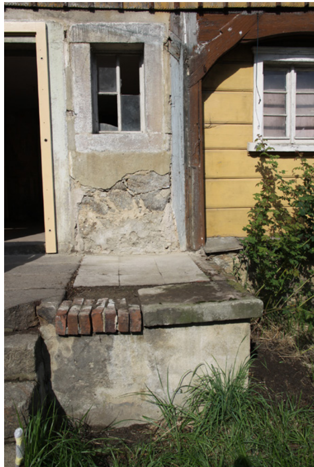
5 Umgebindehaus, Obercunnersdorf/ Oberlausitz, Abgeschnittene Verblattung am Ständer neben der steinernen Türleibung, Zustand 2021
