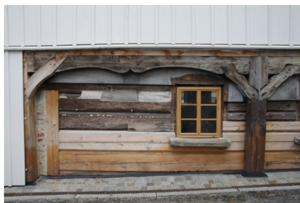
2 Umgebindehaus, Obercunnersdorf/Oberlausitz, Westfassade mit dem weitgespannten Umgebindebogen und den erneuerten Bohlen, Zustand 2024
