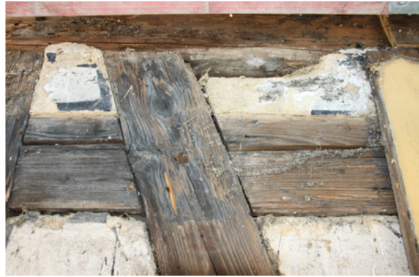
7 Umgebindehaus, Obercunnersdorf/Oberlausitz, Lausitzer Verschlag an der Westseite mit Brett in Traufnähe, das die erste Farbgebung zeigt.
