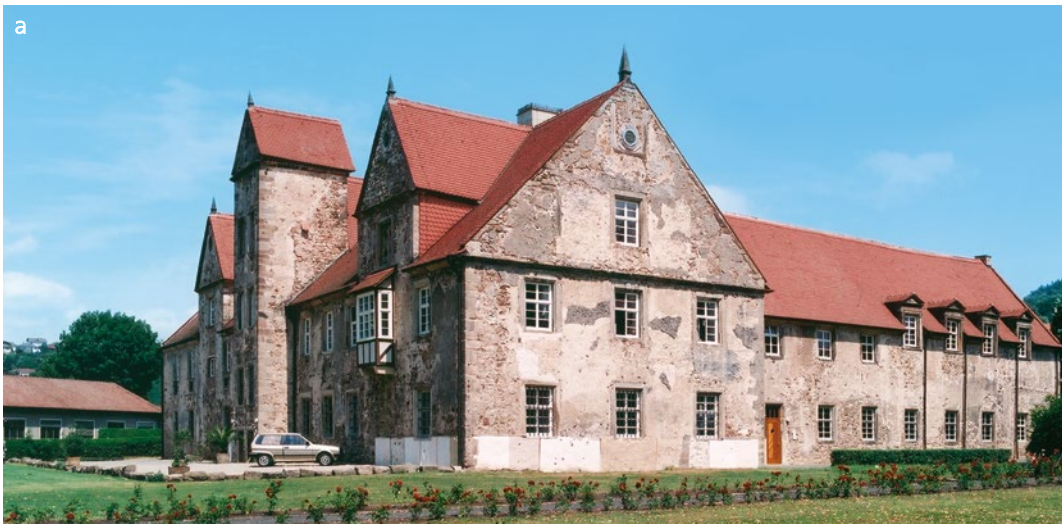
Abb. 2: Ansicht von Südwesten Der Vergleich von a) mit Putzmuster- flächen, 1999 und b) nach der Sanierung 2013 zeigt die aufwen- digen Abstimmungen und Beprobungen der Putz- und Mörtel- zusammensetzungen. Fotos: Ch. Krienke, LfDH, und Th. Büttner
