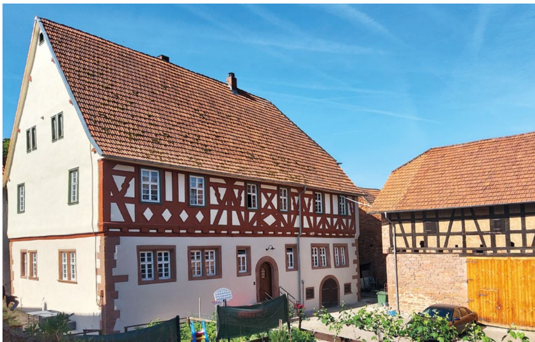
Abb. 2: Der sogenannte Heddersdorf'sche Adelshof nach der Instandsetzung des Wohnhauses
