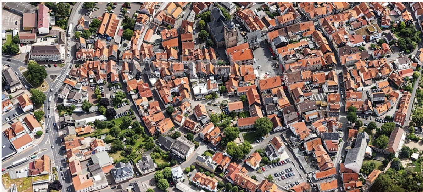
Abb. 1: Luftbild der Stadt Alsfeld, 2019 In der unteren Bildhälfte das Parkdeck der 1960er-Jahre nach Abbruch des Scheunenviertels Foto: D. Reiter, www.euroluftbild.de
