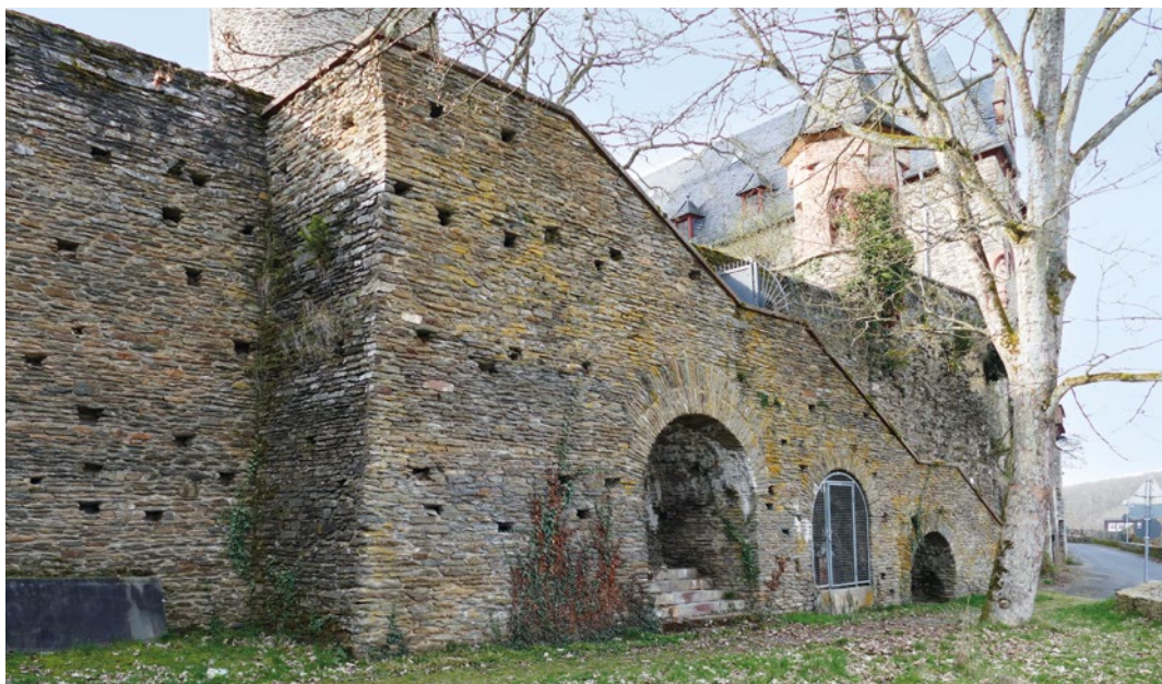
Abb. 2: Bunkeranlage in Schloss Kransberg Hinter der Bruchstein- verkleidung verbirgt sich eine Außenwand des Hochbunkers im Unteren Burghof. Foto: W. Fritzsche, LfDH
