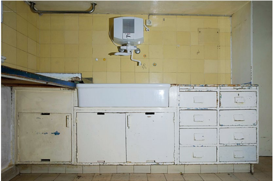
Abb. 4: Sockelbereich für die Küchenmöblierung Unter den Schränken ist ein etwa 10 cm hoher Sockel ausgebil- det. Beispiel einer seit dem Erstbezug nahezu unveränderten Küche in der Römerstadt Foto: F. Müller, Denkmalteam fmk
