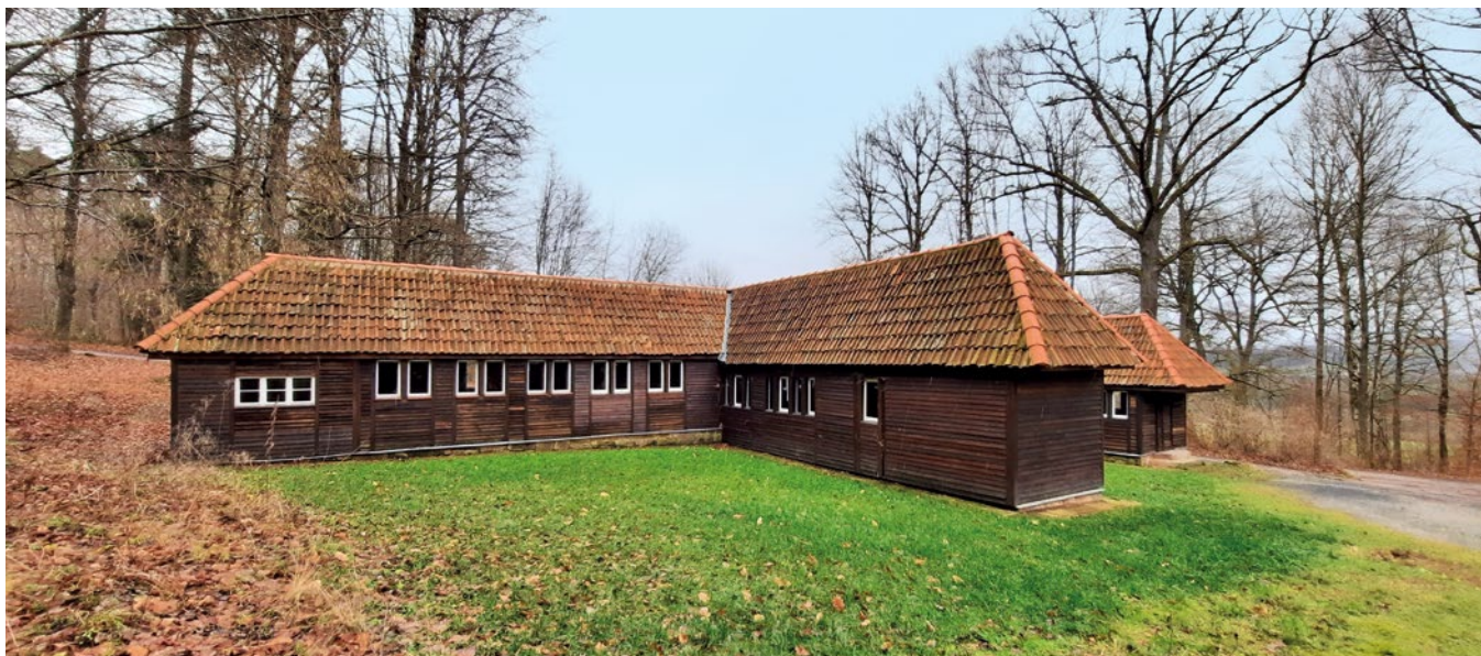
Abb. 1: Dirlos, Lohelandsiedlung, ›Waggonia‹ Aufnahme von Süden nach Abschluss der Maßnahme, 2025 Foto: Archiv Loheland, Anett Matl
