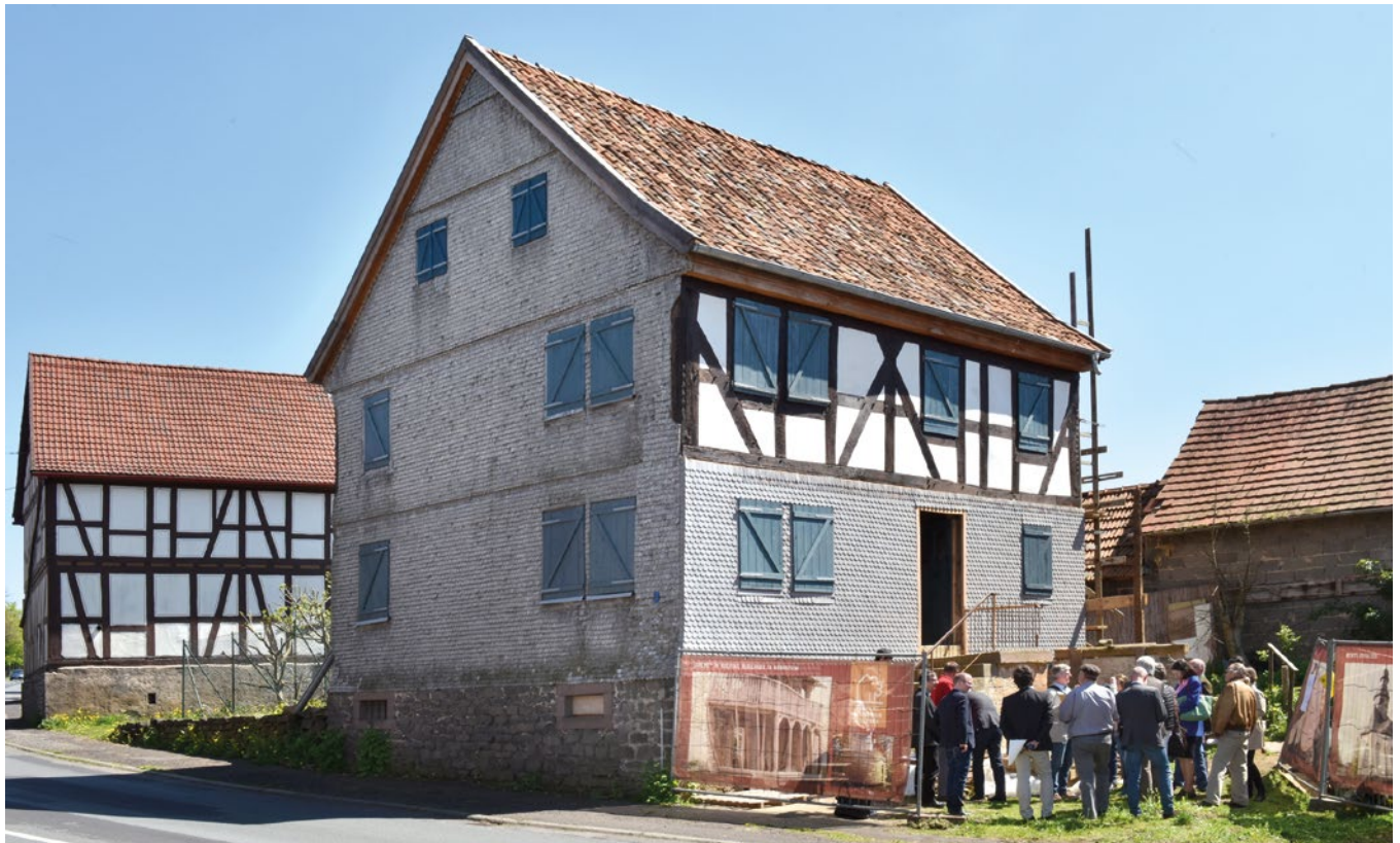
Abb. 10: Alsfeld-Angenrod, Leuseler Straße. Bereisung der Jury des Hessischen Denkmal- schutzpreises, 2017 Foto: Ch. Krienke, LfDH
