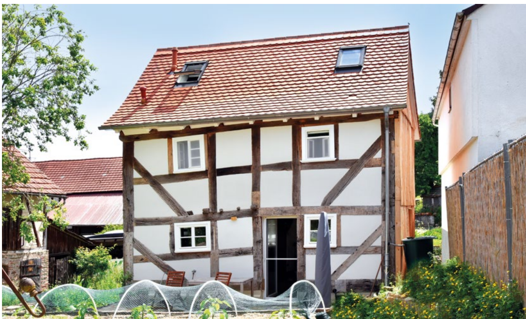
Abb. 1: Ein Haus für sich alleine Das ehemalige Tagelöhnerhaus in Marburg-Dilschhausen Foto: Ch. Krienke, LfDH
