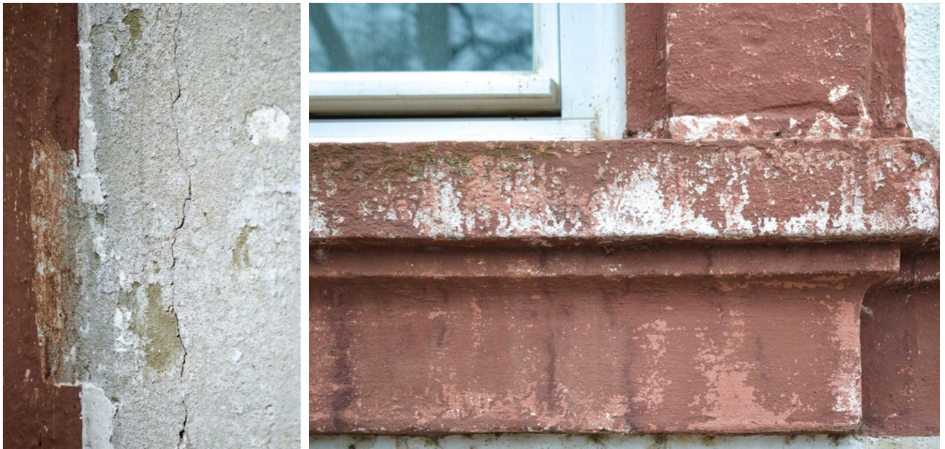
Abb. 2: Unter der historischen Farbfassung findet sich vielfach eine grünliche Fassung, die mit der klassizistischen Umgestaltung in Verbindung gebracht werden kann. Foto: H. Zimmermann, LfDH
