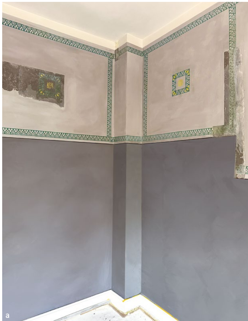
Abb. 8: Schlafzimmerausstattung von Albin Müller: a) rekonstruierte Wandfassung mit integrierten Befundfeldern, 2023, b) Hessische Landesausstellung, 1908 Fotos: a) O. Köhler, UDB Da, b) Institut Mathildenhöhe
