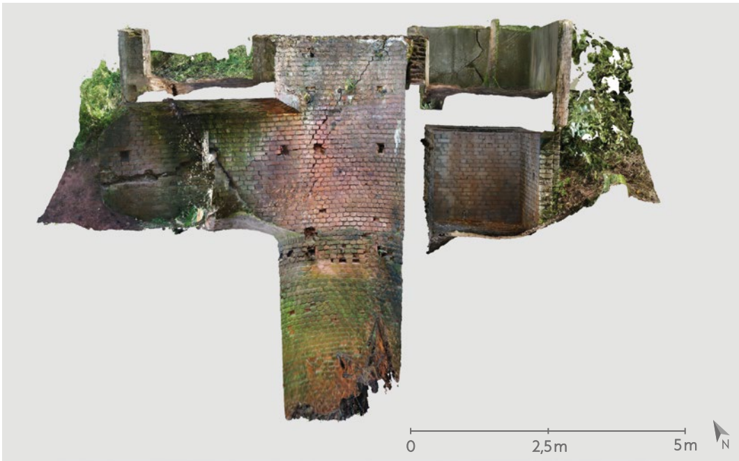
Abb. 9: Förderschacht der Grube Niederstein Der Längsschnitt durch ein 3D-Modell des Förderschachtes zeigt neben der Anordnung der Räume zueinander auch Details der Ausstattungsreste, wie etwa die Fördertechnik. Grafik: M. Pieper, LfDH
