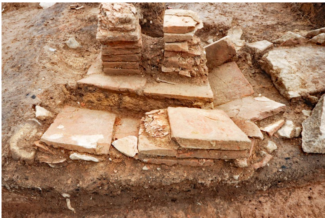
Abb. 8: Ziegelstützen in der Art von Hypokausten Reparaturmaßnahme eines abgesackten Fußbodens Foto: R. Skrypzak, Denkmalamt Frankfurt a. M.
